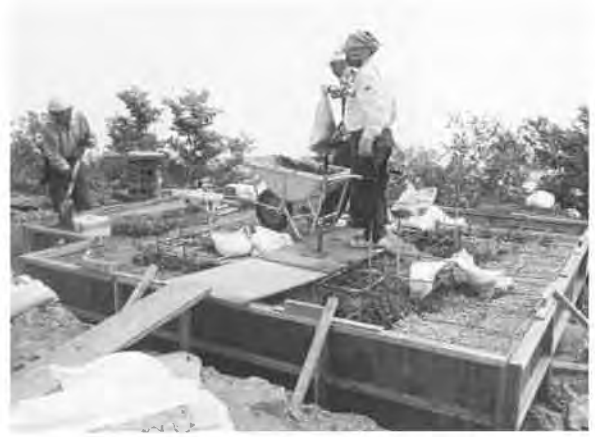
基礎工事の最中でした
