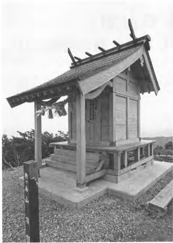
奥宮の完成写真（8月1日完成）
